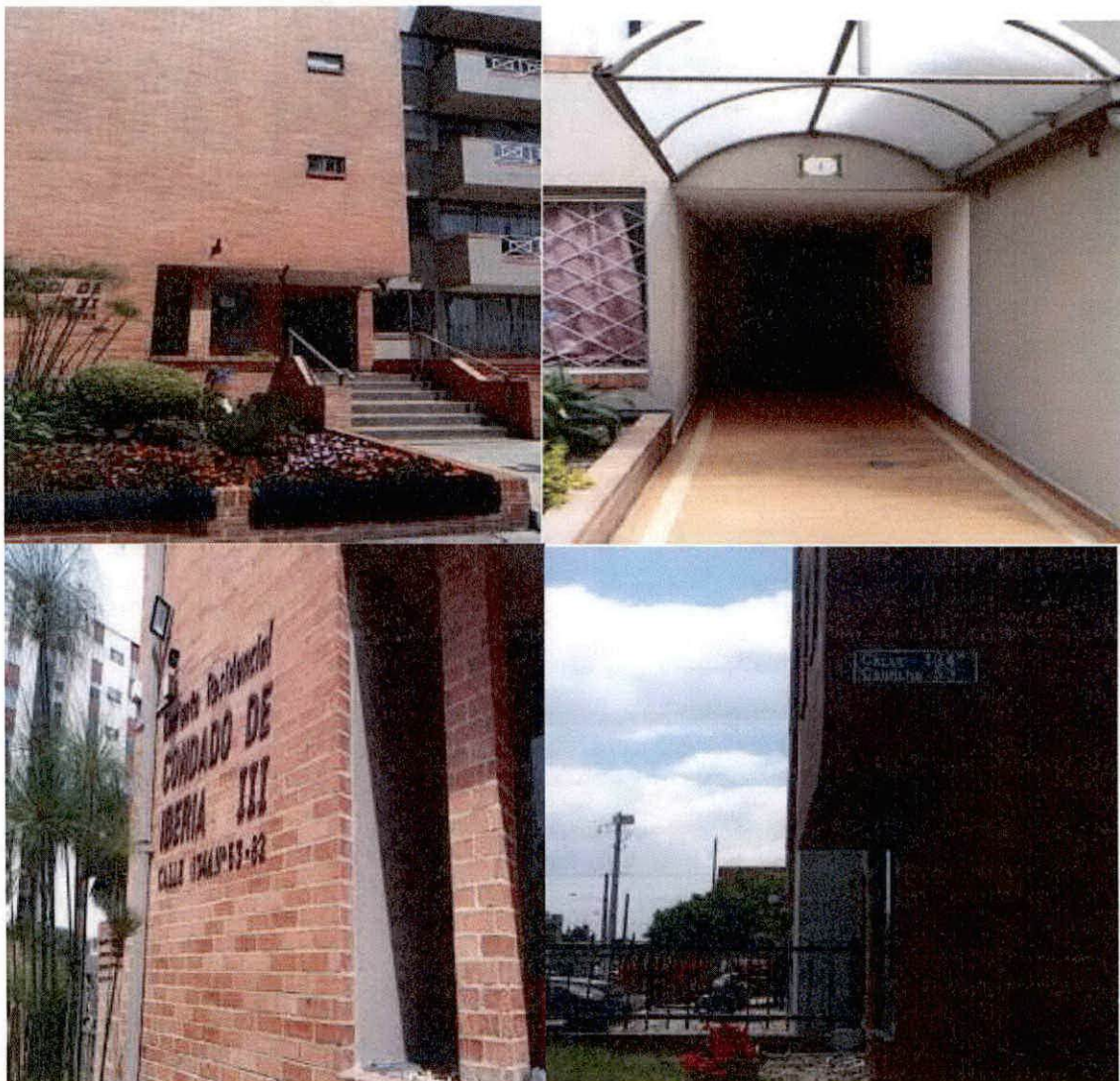
FACHADA DEL CONJUNTO RESIDENCIAL CONDADO DE IBERIA III Y NOMENCLATURA
