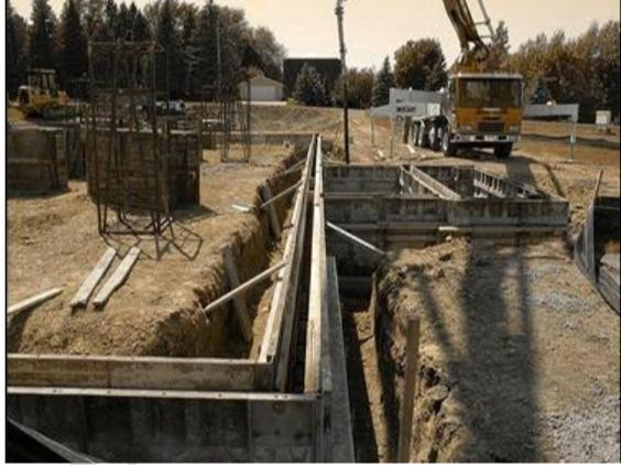
Las zapatas corridas se emplean para cimentar muros portantes, o hileras de pilares. Estructuralmente funcionan como viga flotante que recibe cargas lineales o puntuales separadas, están indicadas como cimentación de un elemento estructural longitudinalmente continuo, como un muro, en el que pretendemos los asientos en el terreno
