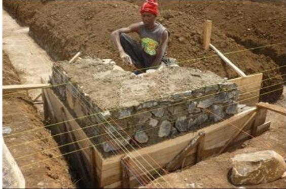
En terrenos cohesivos donde la zanja pueda hacerse con paramentos verticales y sin desprendimientos de tierra, el cimiento de concreto ciclópeo (hormigón) es sencillo y económico. El procedimiento para su construcción consiste en ir vaciando dentro de la zanja piedras de diferentes tamaños al tiempo que se vierte la mezcla de concreto en proporción 1:3:5. El hormigón ciclópeo se realiza añadiendo piedras más o menos grandes a medida que se va hormigonando para economizar materia.
