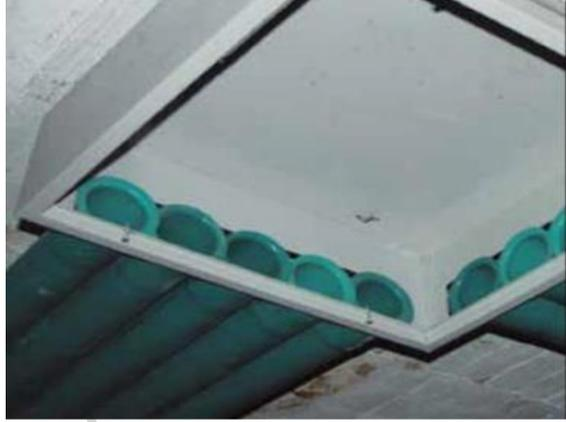
La tubería Conduit en PVC o metálica debe cumplir con certificaciones RETIE. Las cajas de paso como se muestra en la ilustración son utilizadas para la inspección de la tubería, cambios de niveles o cambios de dirección garantizando la conducción de los cables en las instalaciones. El cableado al igual que la tubería vienen de diferentes calibres y variedades según su uso.
