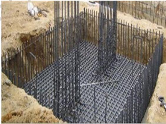
Una zapata combinada es un elemento que sirve de cimentación para dos o más pilares. En principio las zapatas aisladas sacan provecho de que diferentes pilares tienen diferentes momentos flectores. Si estos se combinan en un único elemento de cimentación, el resultado puede ser un elemento más estabilizado y sometido a un menor momento resultante.
