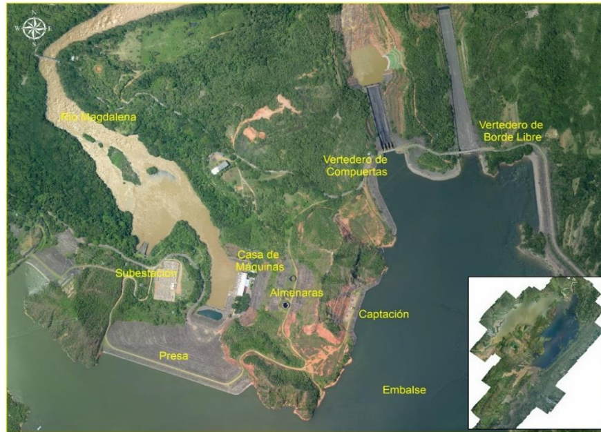
Figura 7-1. Identificación de obras de la Central Hidroeléctrica de Betania. Fuente: ENEL COLOMBIA S.A. E.S.P.
