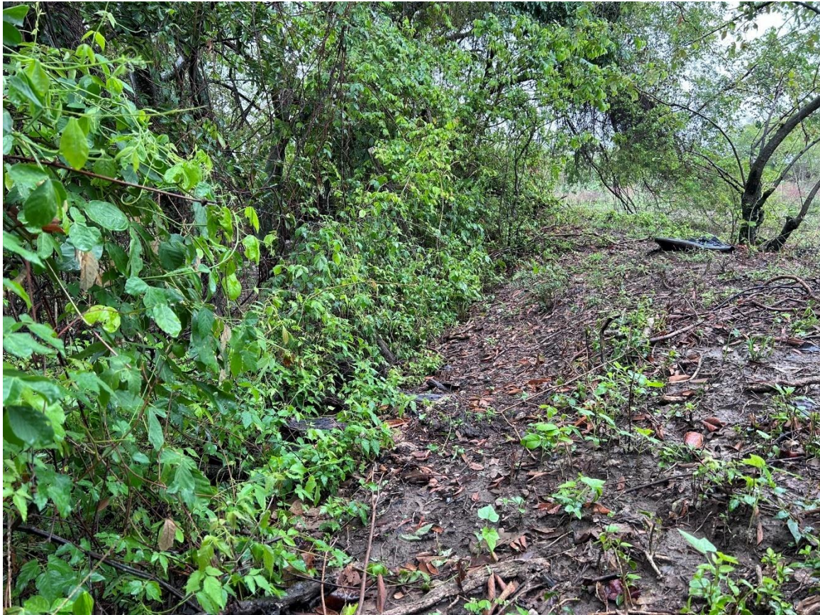
Fotografía 6. Jarillón de Riego bordeando la Quebrada La Canchosa (Punto 5 en la Fotografía 1). Durante el recorrido y en algunos tramos se evidencia la existencia de un jarillón con fines de riego.
