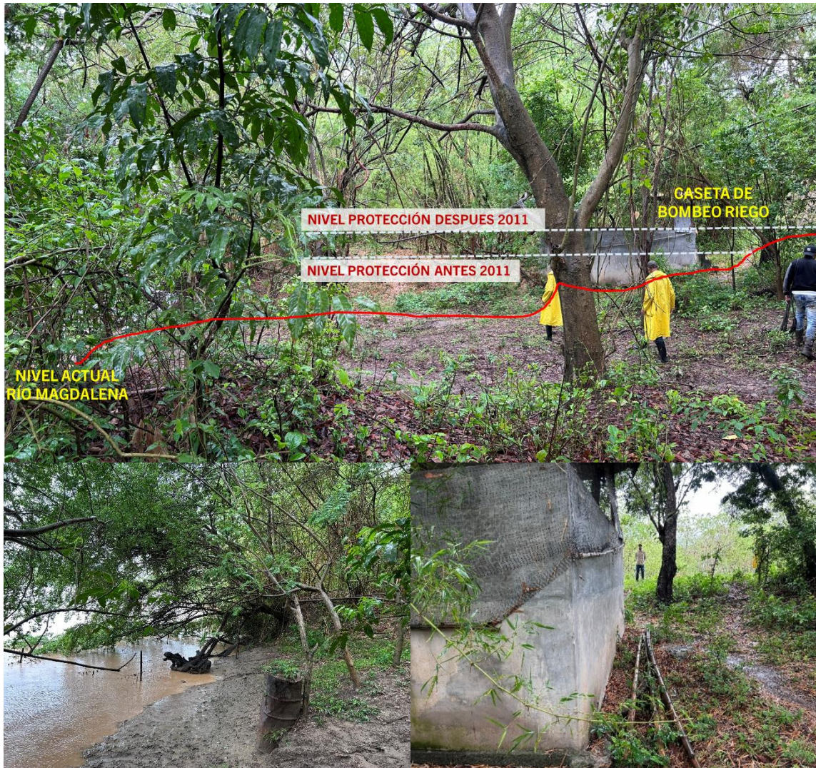
Fotografía 8. Perfil Transversal del Predio El Higuierón con el Río Magdalena (Punto 7 en la Fotografía 1). Arriba. Vista de perfil del final del predio El Higuierón con el río Magdalena, como se puede apreciar, la diferencia de nivel entre el río Magdalena y el plano general del predio es de alrededor de 5-6 metros. Abajo Izquierda. Nivel del río Magdalena el 4 de noviembre de 2023. Abajo Derecha. Se observa el nivel inicial de la infraestructura de riego y el aumento que surgió luego de los eventos de inundación según narró el acompañante en la visita el Sr. Jhon Repizo.
