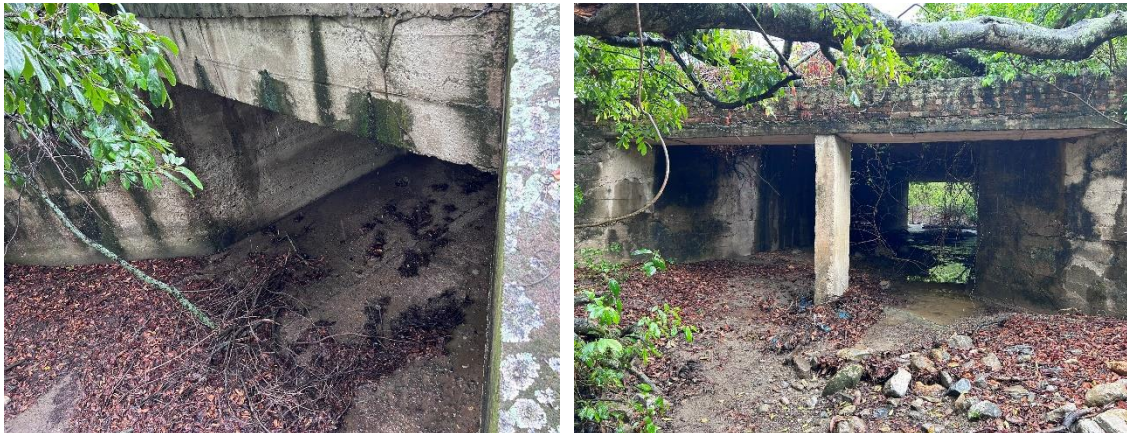
Fotografía 2. Boxculvert sobre la vía Neiva-Bogotá (Punto 1 referenciado en la Fotografía 1). Se observa la gran capacidad de la obra hidráulica para habilitar el paso de la Quebrada La Canchosa al río Magdalena.
