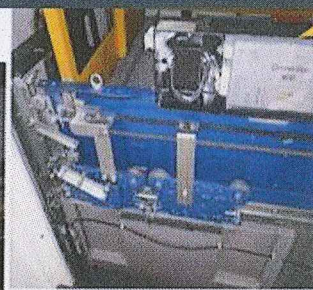
Fig 2 Operador de puertas
