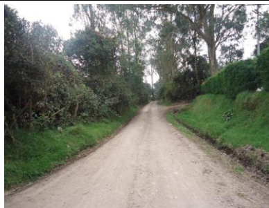
Vía Pública de Acceso
