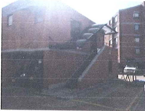
Edificio zona social
