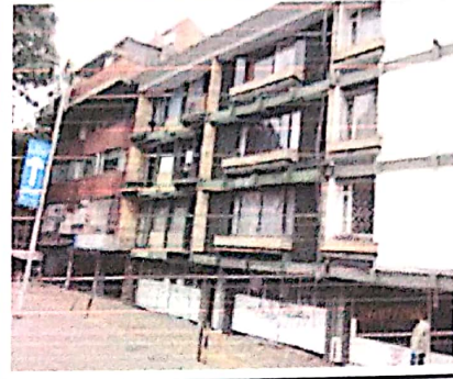
FACHADA GENERAL DEL EDIFICIO
