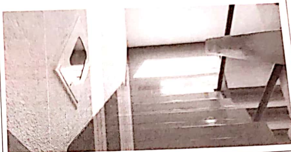
Escaleras de la torre
