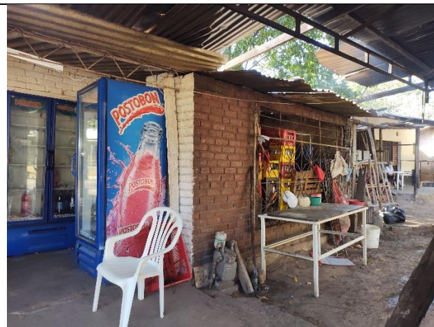
C9- Construcción - detalle
