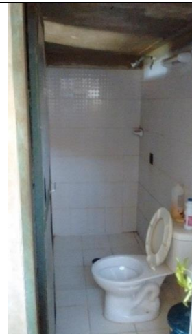
C4- Construcción - detalle
