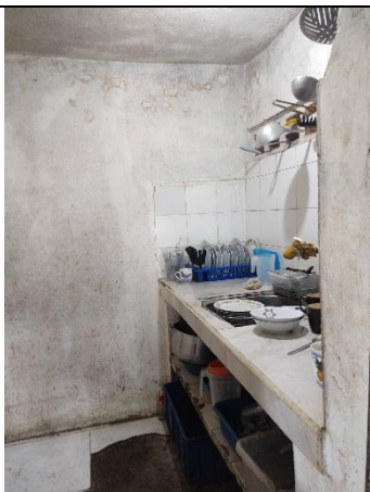
C9- Construcción - detalle
