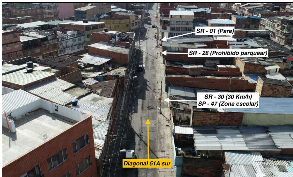
Imagen 13. Panorámica de la Diagonal 51 A sur norte a sur, vía por donde circulaba el vehículo (2) motocicleta se observa señalización vertical y horizontal.
