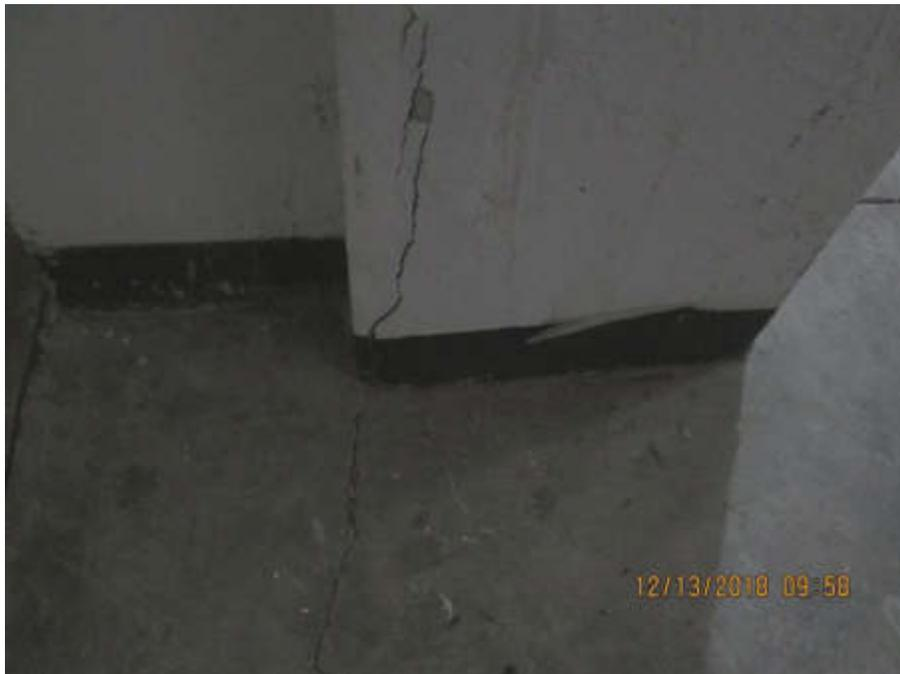
Figura 82 – Fisuras en placa de cimentación y dilatación.
