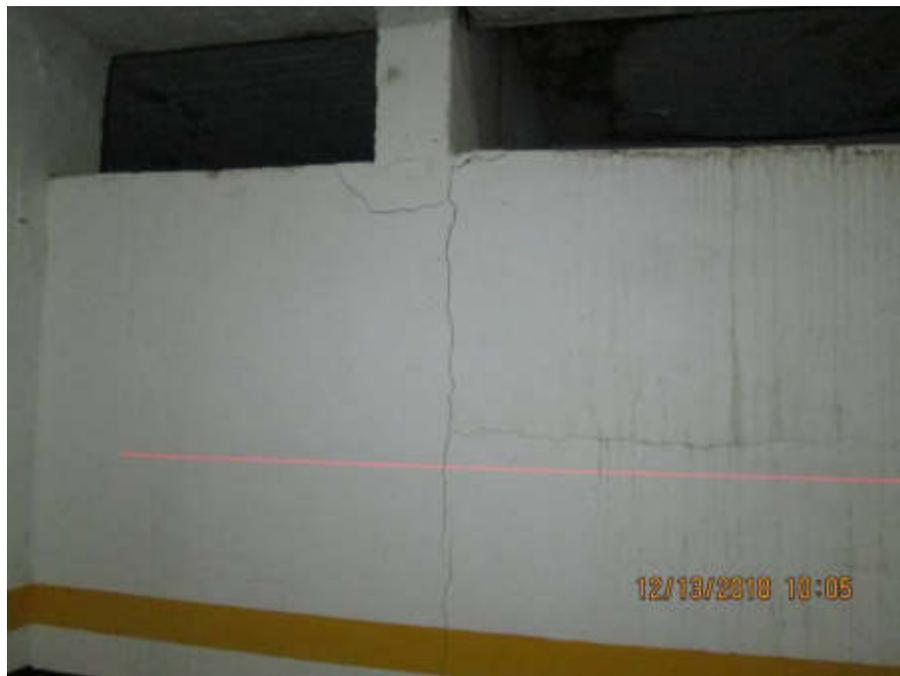
Figura 86 - Fisuras en muros de Sótano.
