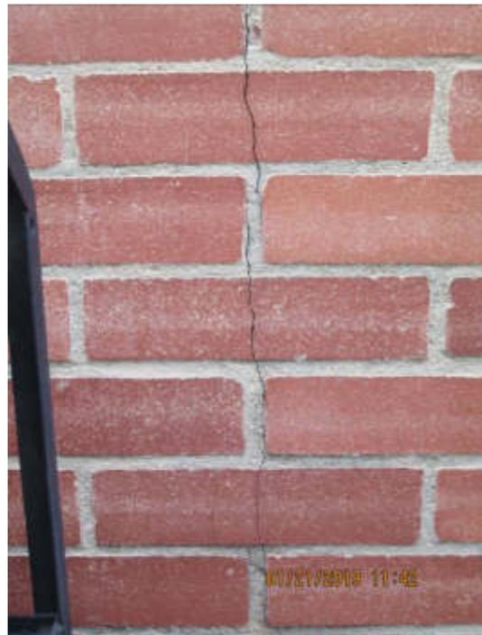
Figura 70 –Fisuras en muros
