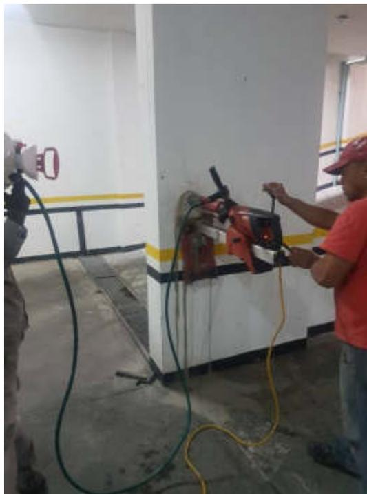
Figura 21– Extracción de núcleo en pantalla.
