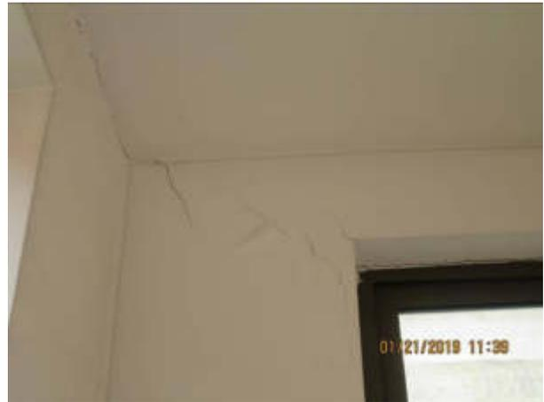
Figura 69 –Fisuras en muros en balcón.
