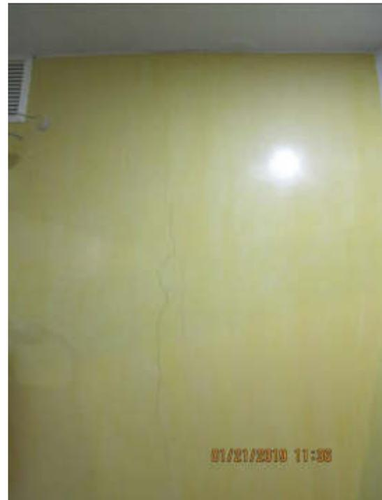
Figura 68 –Fisuras en muros en baño
