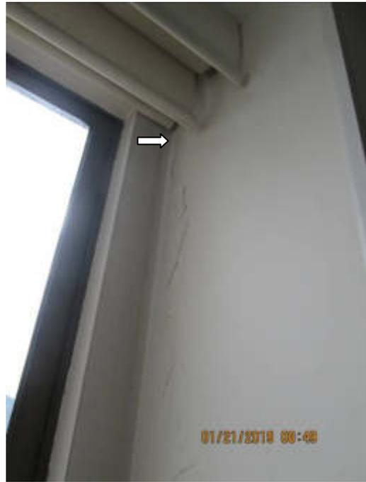
Figura 65 – Fisuras en muros de ventana alcoba principal
