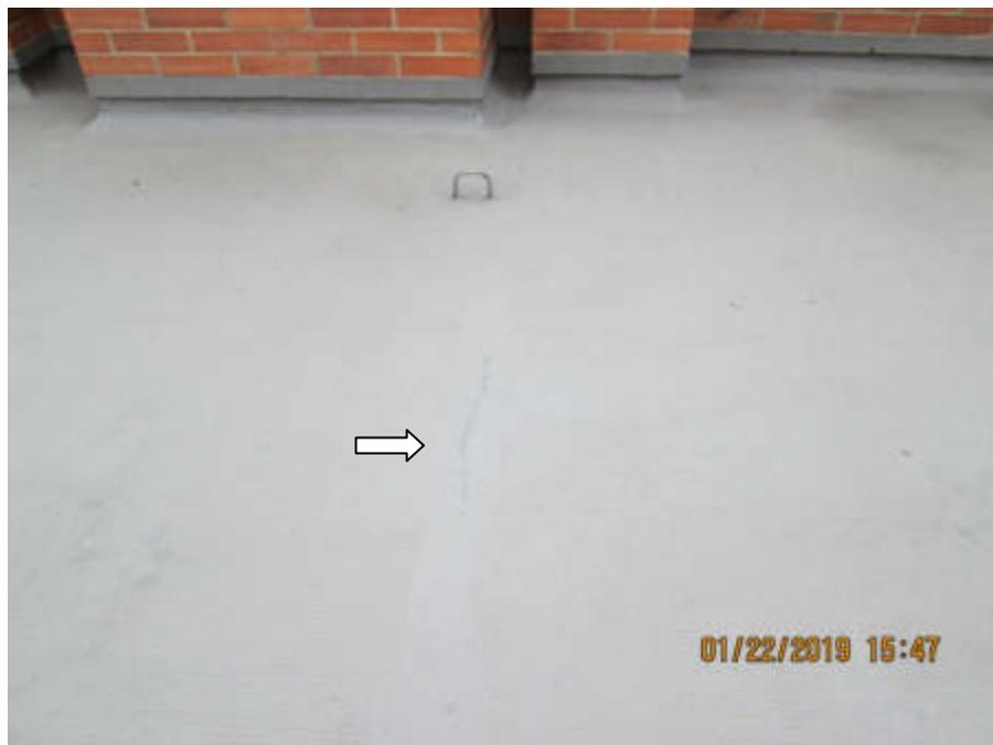
Figura 109 - Fisuras en cubierta.
