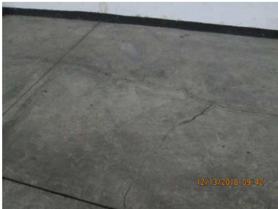
Figura 80 – Fisura en placa de Sótano.
