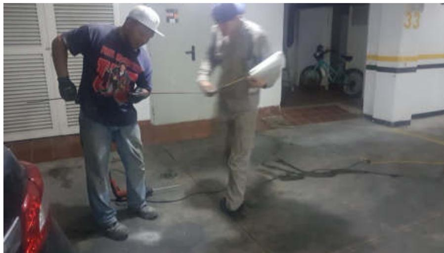
Figura 59– Proceso de perforación de la placa de cimentación para evaluar el nivel de agua dentro de los casetones.
