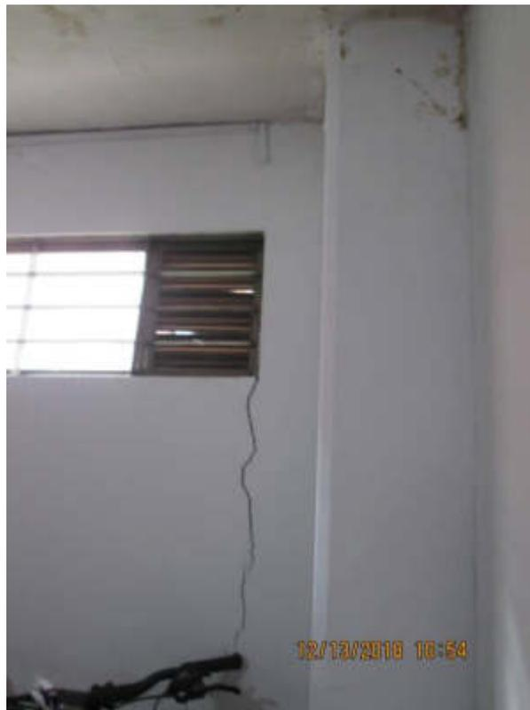
Figura 102 – Fisuras en muros.
