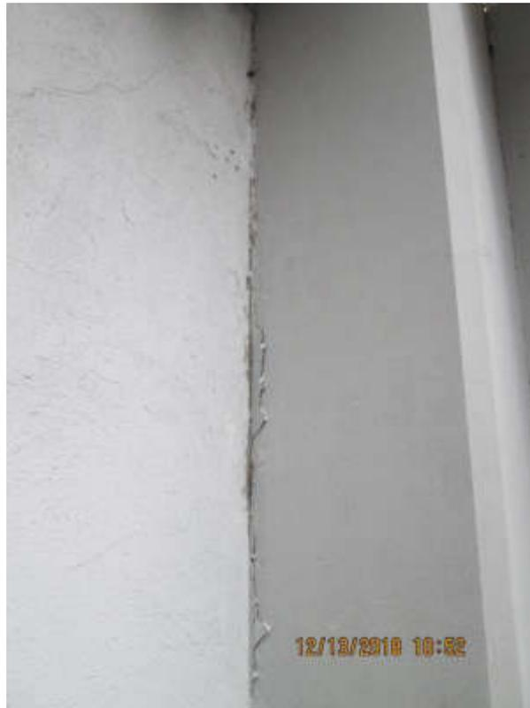
Figura 94 – Dilatación en muro.
