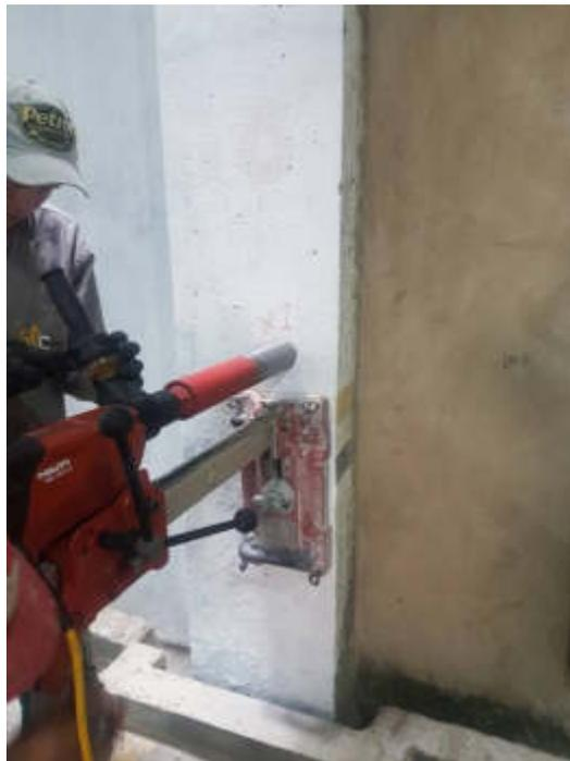
Figura 19– Extracción de núcleos en columna del Sótano.
