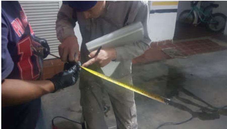
Figura 60– Proceso de perforación de la placa de cimentación para evaluar el nivel de agua dentro de los casetones.
