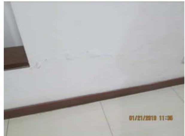
Figura 67 – Apartamento 203-Fisuras en muros
