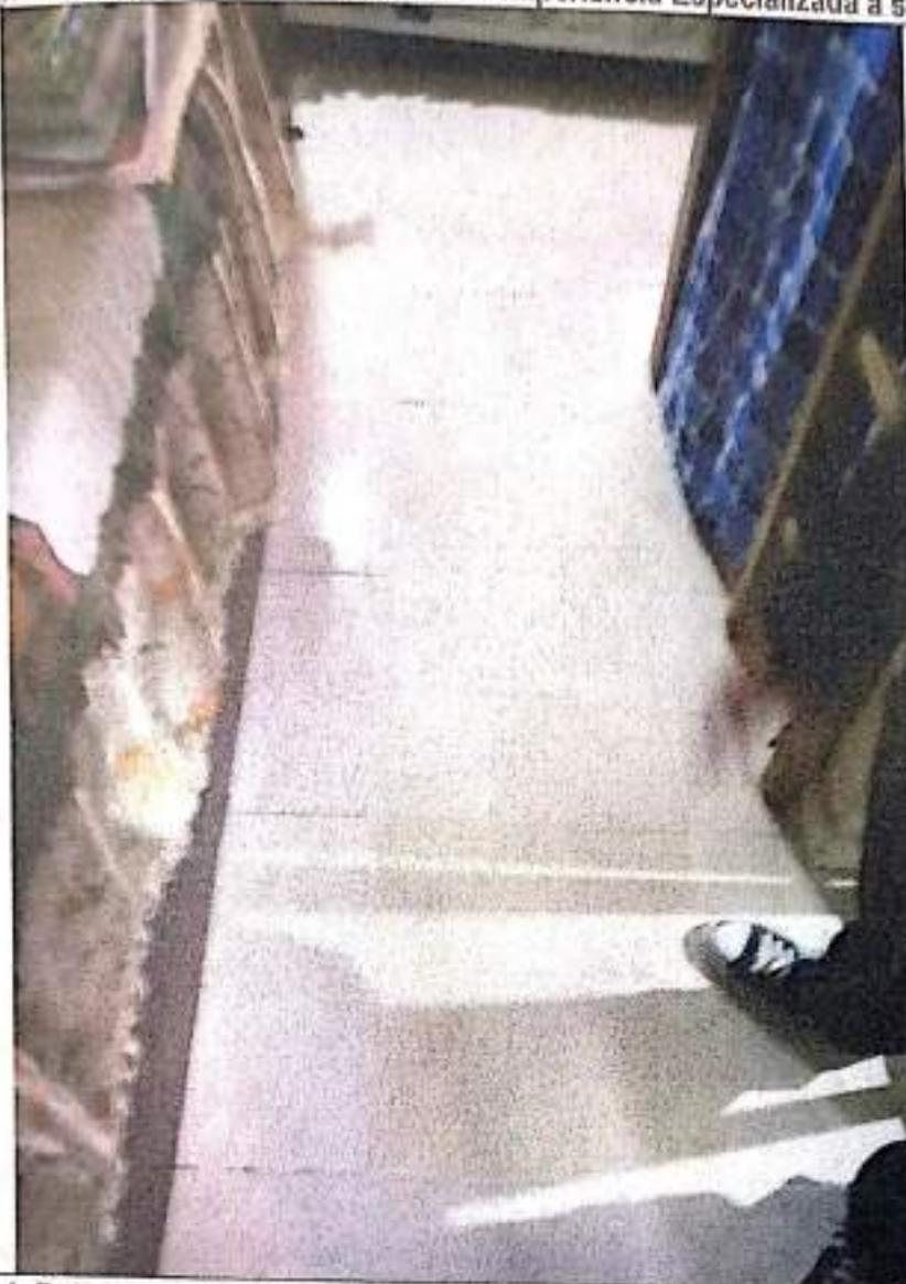
Ilustración 4. Daños en antepechos, grietas. Tabletas levantadas y fisuradas. Barrio Tibabuyes Universal Bogotá octubre 2020. Fuente Propia.
