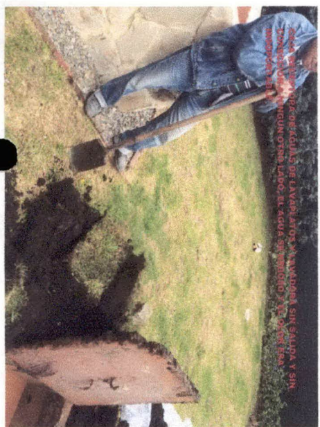
CAJA RECEPTORA DE AGUAS LAVA PLATOS Y LAVADORA SIN SALIDA Y SIN CONEXION A NINGUN OTRO LADO, EL AGUA SE REBOSO Y LOS OLORES ERAN INSOPORTABLES.
