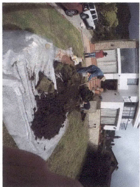
CAJA RECEPTORA DE AGUAS DE LAVAPLATOS, LAVADORA SIN SALIDA Y SIN CONEXION A NINGUN OTRO LADO, EL AGUA SE REBOSO Y EL OLOR ERA INSOPORTABLE
