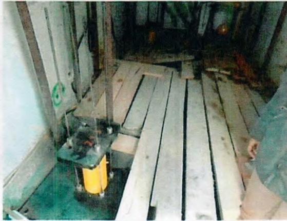
Fotografía 14. Obras de reforzamiento de la cimentación en las torres 5 y 6
