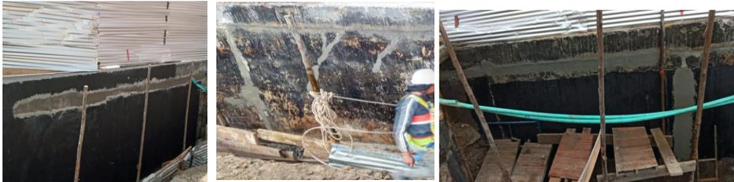
**5. Impermeabilización de muro con cemento marino:**
