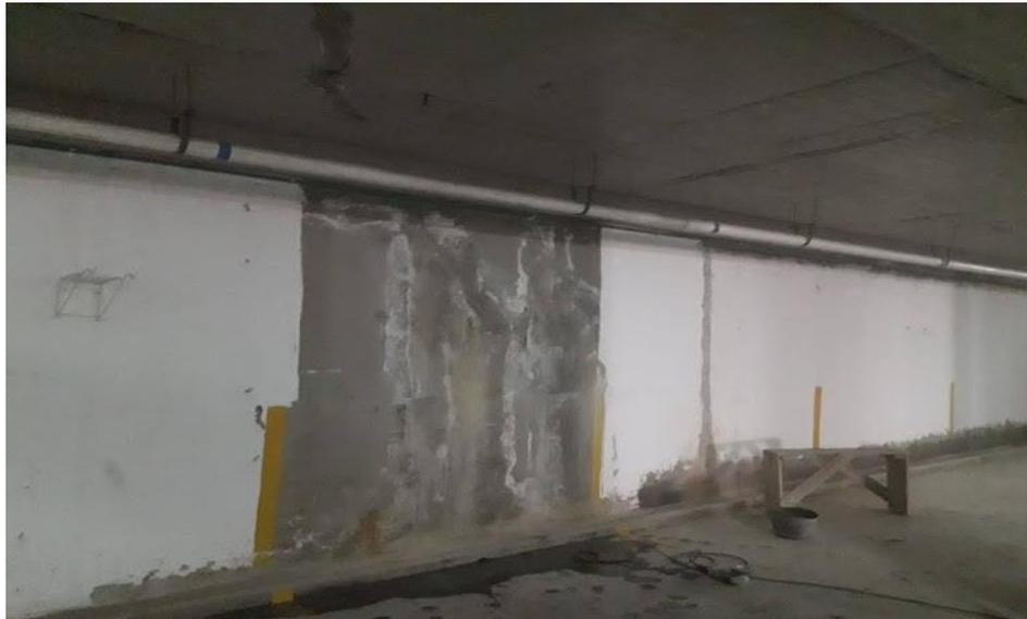
**14. Impermeabilización de muro con cemento marino:**
