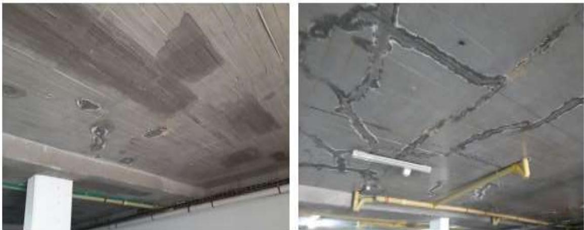
Fisuras observadas por debajo de losa en patrón diagonal contra intersección en esquinas de los muros de contención por restricción adicional al movimiento.
