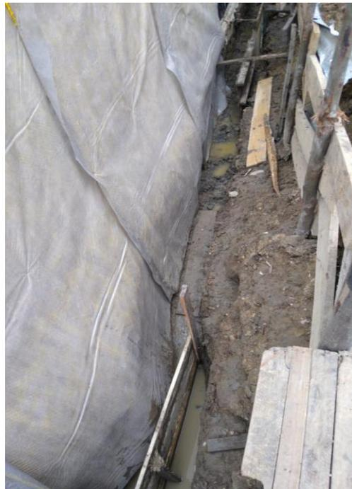
**7. Instalación de filtro (tubería) envuelto en GEODREN y conducción de aguas a caja para pozo eyector:**
