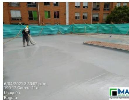
**4. Suministro y aplicación de sistema de poliurea en caliente Hyperdesmo HC, de 2mm de espesor, aplicada con equipo reactor.**
