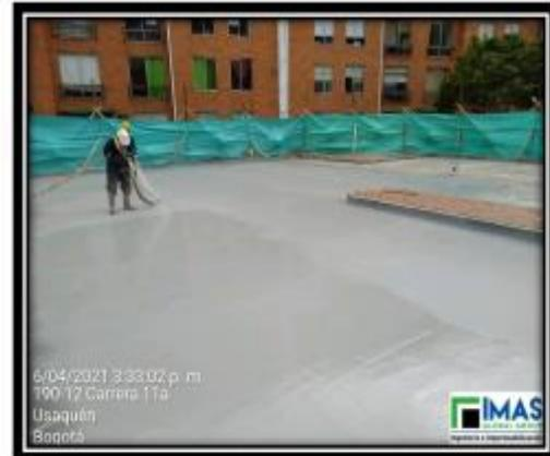
*Detalle de aplicación de sistema de poliurea en caliente 2mm*
