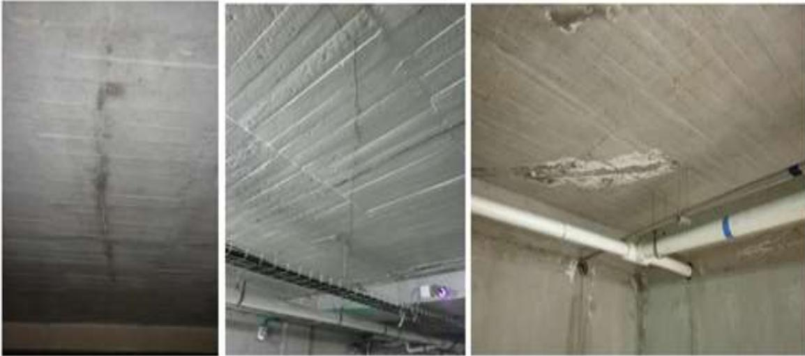
Fisuras observadas por debajo de losa, en patrón diagonal contra intersección en esquinas de los muros de contención por restricción adicional al movimiento.
