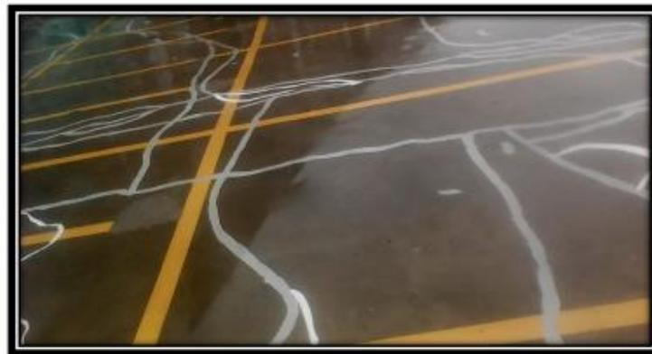
*Detalle de aplicación de imprimación sistema de poliurea en caliente*
