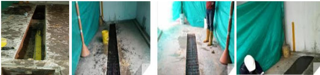
**8. Relleno con recebo tipo B200, con capas de 15cm de espesor como máximo a una densidad no inferior al 85% en el Proctor Modificado:**
