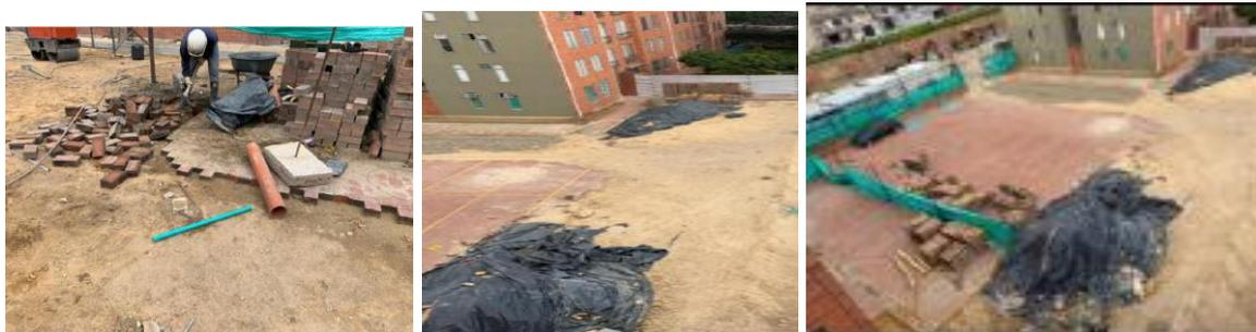
2. Excavación de 33mts x 3mts con talud y realización de terrazas para cumplimiento SST:
