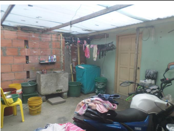
VISTA PATIO INTERNO VIVIENDA 2° PISO
