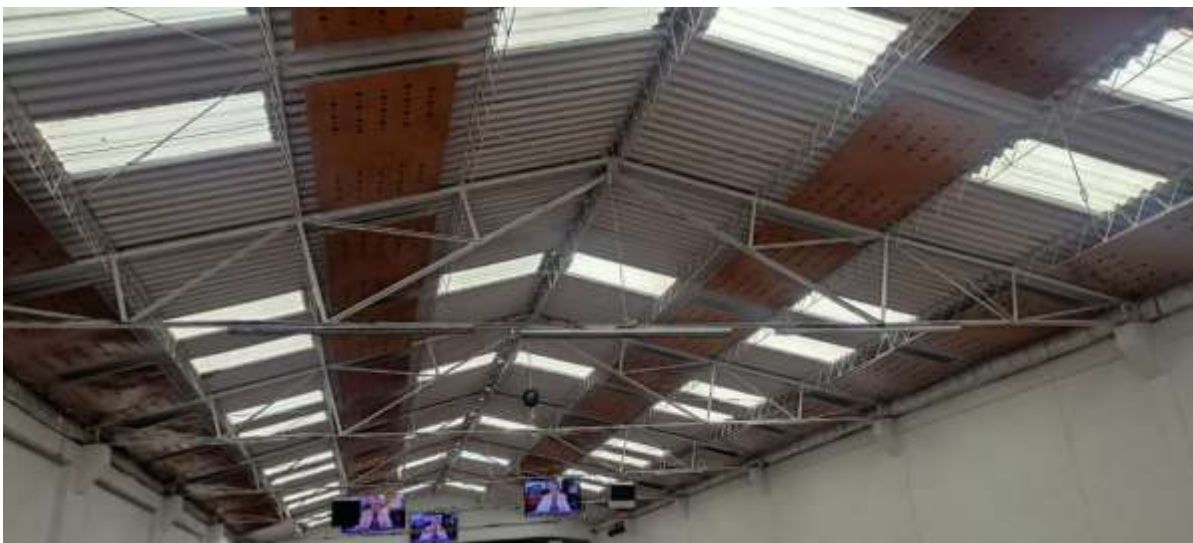
Ilustración 5 cerchas metálicas y cubierta
