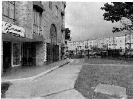
Fachada lateral, local 101(peluqueria), sentido noroccidente
