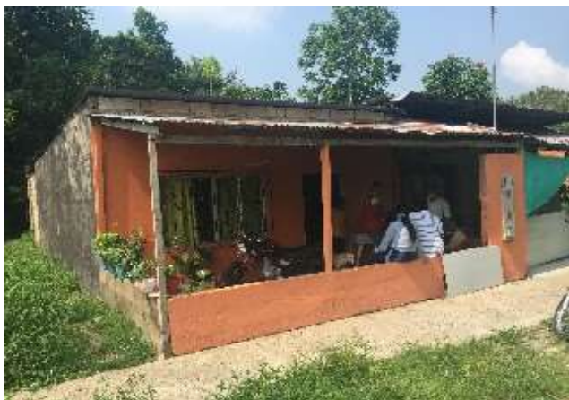
FACHADA PRINCIPAL - NORTE
