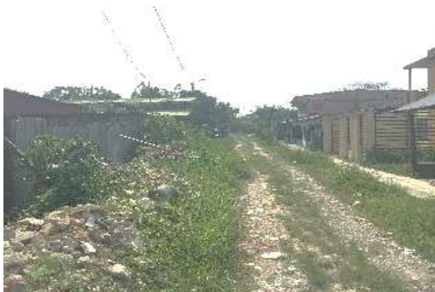
VIA VEHICULAR VISTA DE OESTE A ESTE
