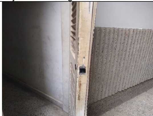
Edificio Lara Bonilla Primer Piso
