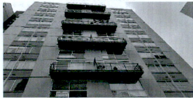
Fachada del Inmueble
