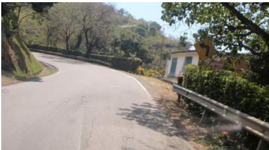
3.- Señal Preventiva SP-01, que significa "CURVA PELIGROSA A LA IZQUIERDA", ubicada en el PR47+670, Margen Izquierdo de la Vía.
