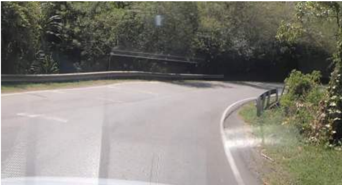
5.- Pontón Chapata, ubicado en el PR47+418, margen Izquierda de la Vía.
