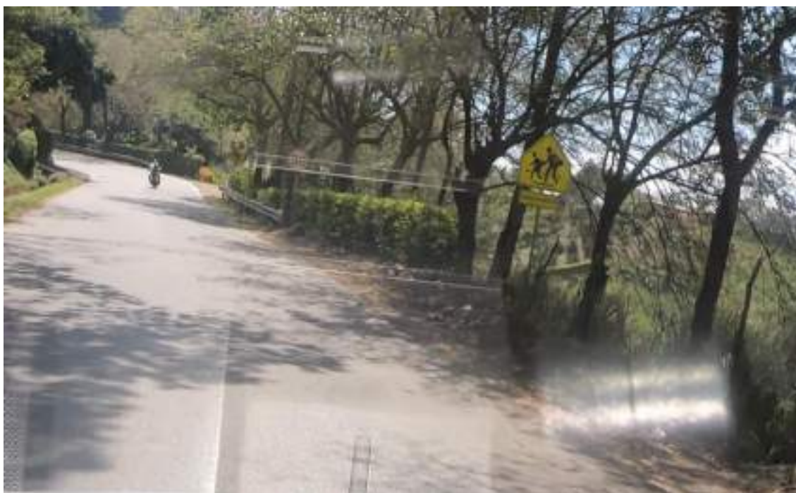
1.- La cual muestra la señal Preventiva SP-47se encuentra ubicada en el PR47+711, Margen Izquierdo de la vía, señal que significa "ZONA ESCOLAR". También puede observarse la señal reglamentaria SR-30(30), de máximo de Velocidad de treinta (30) kilómetros por hora. También puede observarse, la señal preventiva SP-01, que significa "CURVA CERRADA A LA IZQUIERDA".
