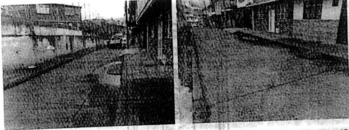
A lo largo de dicha vía, sin embargo, si se observa como se evidencia en el registro fotográfico, viviendas cuyos bajantes de aguas lluvias, escurren directamente sobre la vía, recargando en gran medida la buena evacuación de las aguas de escorrentía del sector, provocando de esta manera que el agua se empoce en los puntos más bajos de la vía, generando inundaciones y humedades hacia las mismas viviendas.
