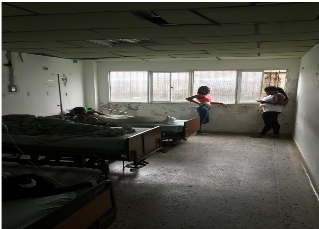
Habitaciones, paredes y techos de la ESE
