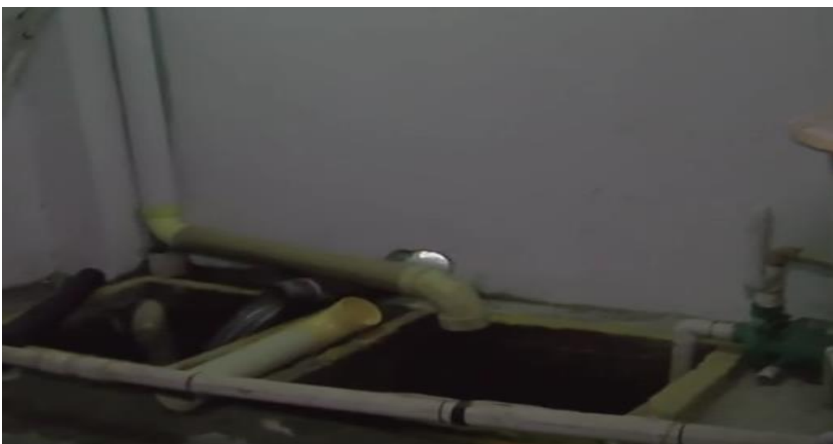
Bocatoma de la planta de tratamiento
