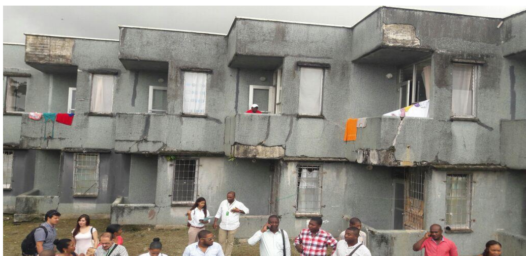
Habitaciones de medicina interna desde la parte de atrás del Hospital.
