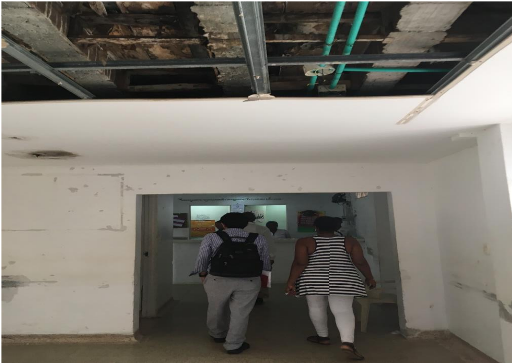
Pasillos, paredes y techos de la ESE
