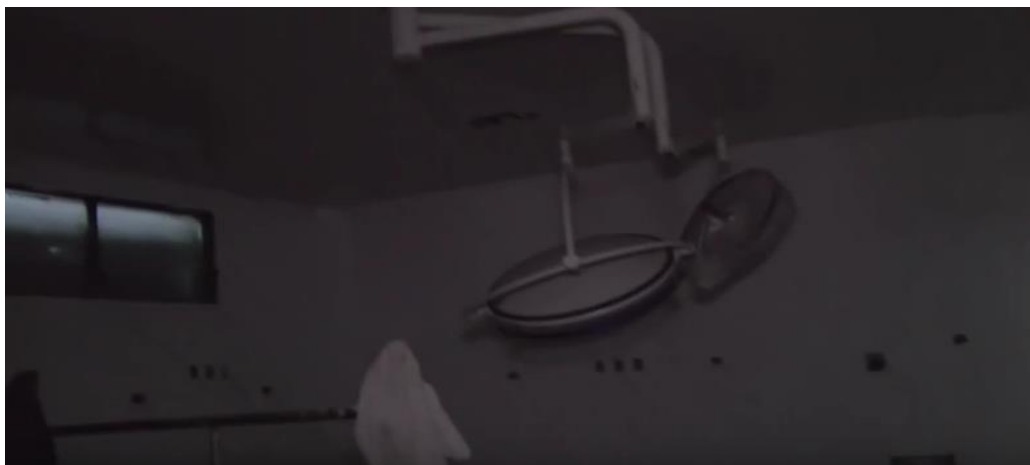
Quirófanos en remodelación
