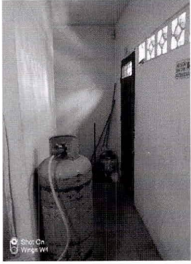
PASILLO A PATIO Y BAÑO
