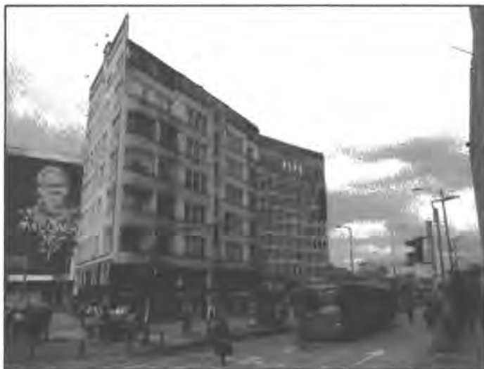
FACHADA DEL EDIFICIO NUEVO CENTRO COMERCIAL SAN VICTORINO
