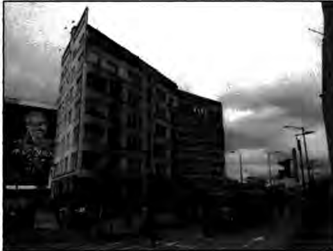
FACHADA DEL EDIFICIO NUEVO CENTRO COMERCIAL SAN VICTORINO
