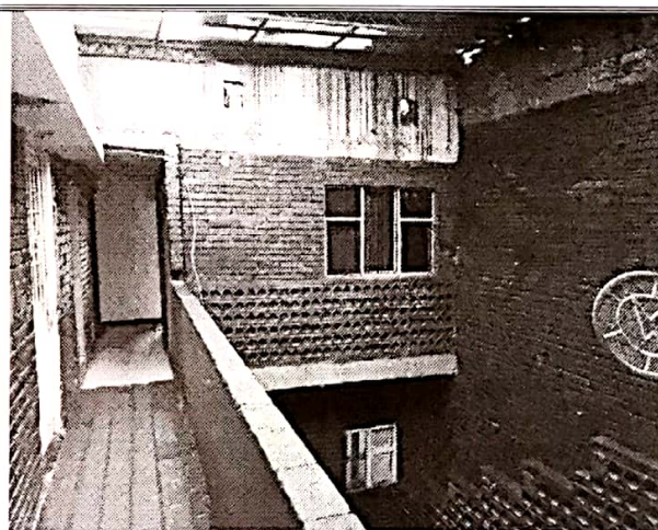
ACABADOS CASA TERCER PISO
