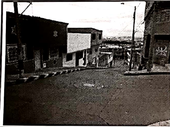
VISTA DEL SECTOR
