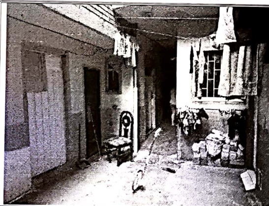
ACABADOS CASA PRIMER PISO
