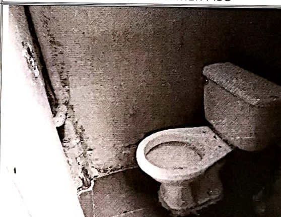
ACABADOS CASA PRIMER PISO
