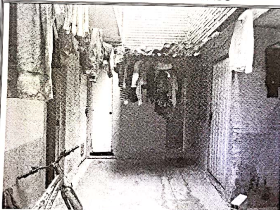
ACABADOS CASA PRIMER PISO
