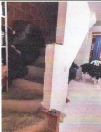
ESCALERAS ACCESO PISO 2
