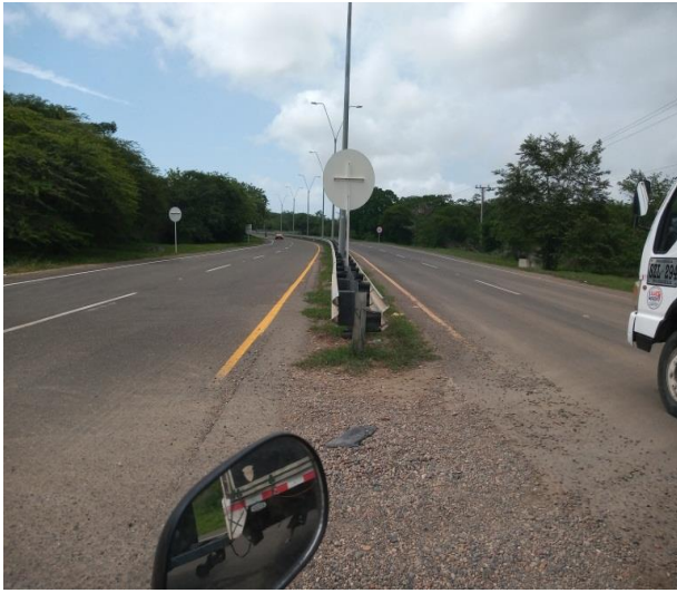
DOBLE CALZADA CARRETERA VIA DEL MAR
