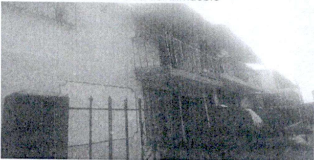
Fachada del Inmueble
