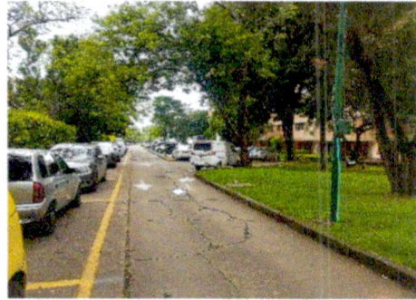
Vías de circulación y parqueo
