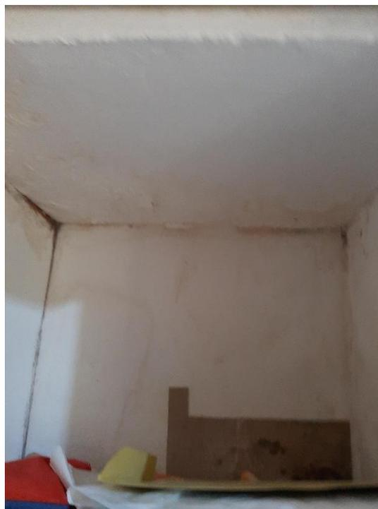
**FOTOS 3 Y 4. MALETERO DEL CLOSET DE ULTIMA HABITACION CON FUERTE HUMEDAD Y OLOR Y NO SE PUEDE UTILIZAR.**
