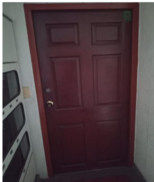
PUERTA ENTRADA PARTE EXTERIOR
