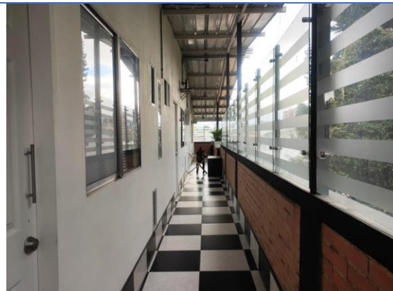
Pasillo de circulación lado oriente, vista sur – norte, 3er piso
