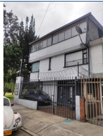
Otro aspecto de fachada
