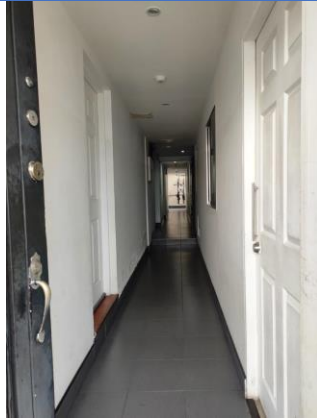
Corredor de acceso 1er piso, vista norte – sur
