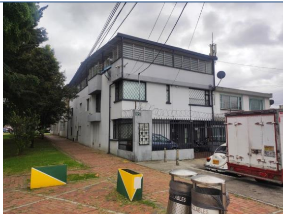
Fachada general del edificio
