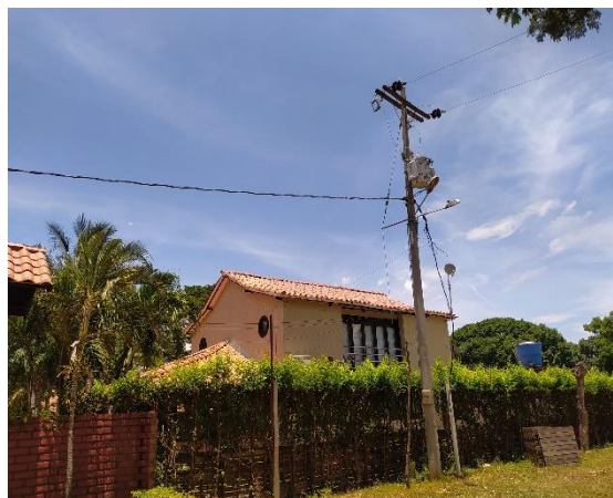
VISTA EXTERNA DE VIVIENDA PRINCIPAL
