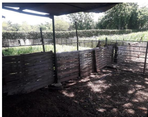
CERRAMIENTO ALEDAÑO A CORRAL
