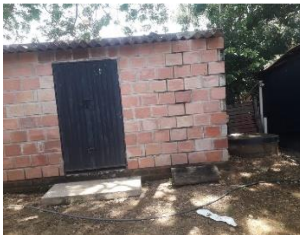
CUARTO DE MAQUINAS
