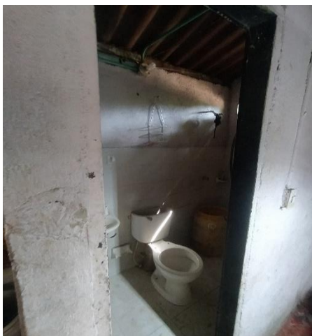
BAÑO VIVIENDA DE TRABAJADORES
