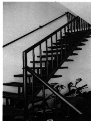
ESCALERA AL SEGUNDO PISO
