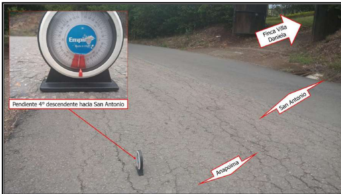
Imagen 2.6 Condiciones de la vía
