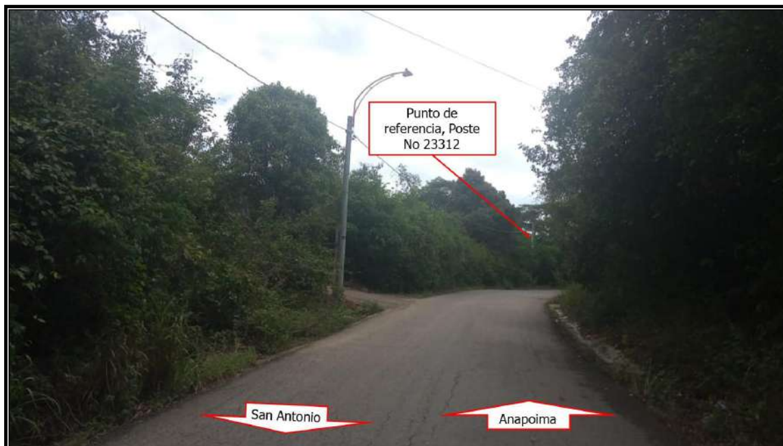
Imagen 2.10 Condiciones de la vía
