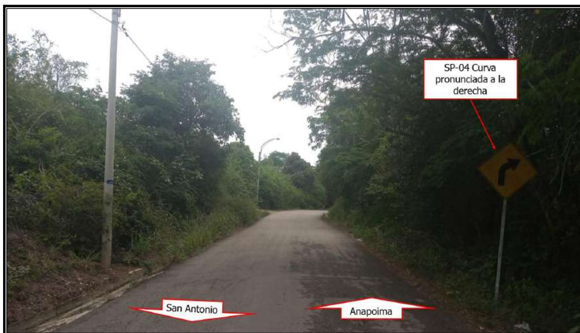
Imagen 2.9 Condiciones de la vía
