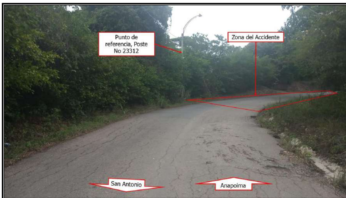
Imagen 2.11 Condiciones de la vía
