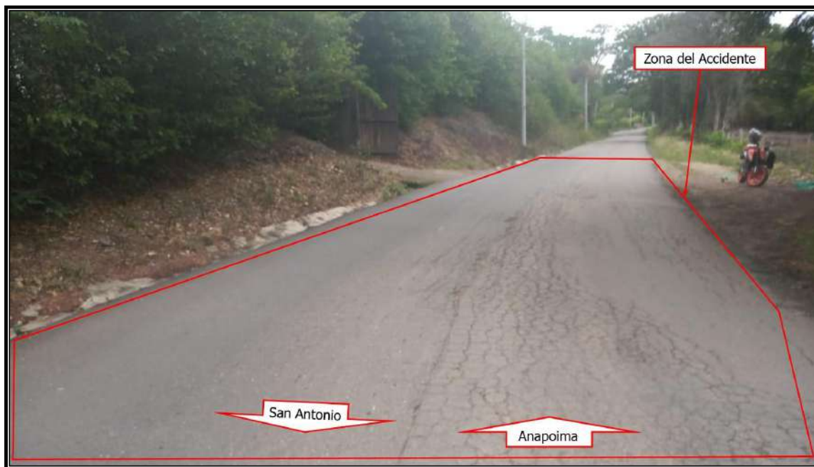
Imagen 2.13 Condiciones de la vía
