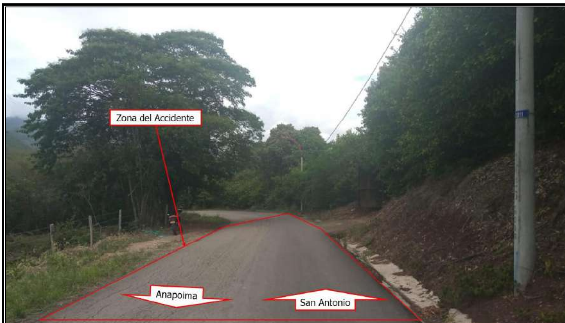
Imagen 2.4 Condiciones de la vía
