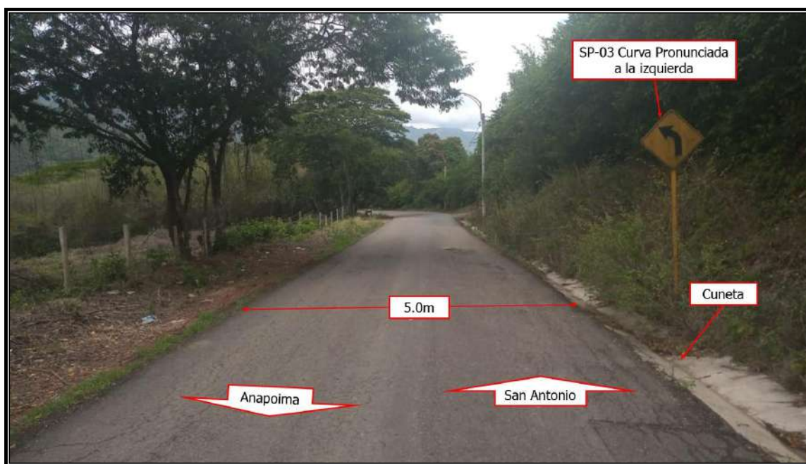
Imagen 2.3 Condiciones de la vía
