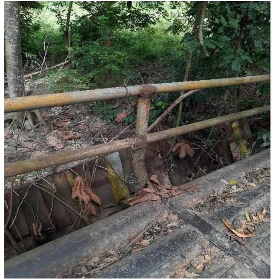
**Fotografía No. 4** Estado actual del puente con las vigas de soporte o amarre reventadas, las cuales brindan seguridad y resistencia al mismo.
