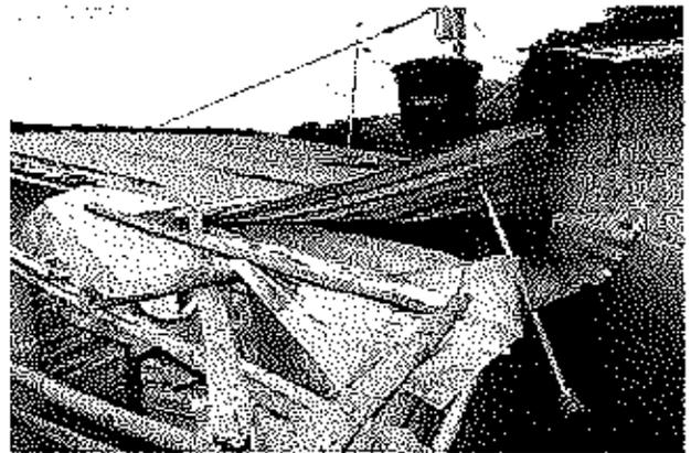
**Fotografía N° 22:** Se observa el levantamiento de la teja de zinc.
