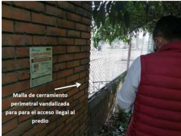
**Imagen N° 9 Detalle de los sitios de la malla del cerramiento perimetral vandalizados y remendados, dichos daños son realizados presuntamente por terceros para el acceso al predio. Costado sur del predio, aledaño a sitios con presencia de hojas cortadas por terceros que ingresan sin autorización al lote a recolectar hojas jóvenes de Eucalipto para su posible comercialización.**
