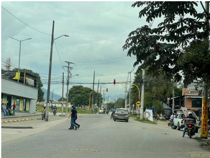
Fotografía 3. Avenida Ambalá carril subiendo
