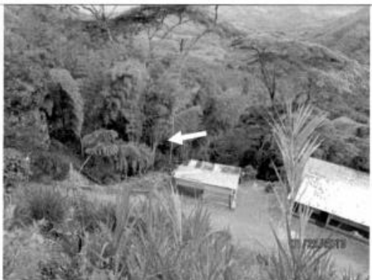
IMAGEN 8 TOMA 0014. Ilustra en el centro el cuarto de herramientas y se señala con una flecha la parte por donde inicia la ruta hacia el sitio señalado como caleta número dos (2) donde fue encontrado el material bélico.
