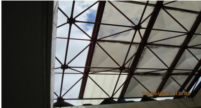
Foto No. 2.- La estructura de la cubierta existente se encuentra en buenas condiciones, por lo que se debe dejar y trabajar la cubierta encima, es necesario pintar la estructura.
