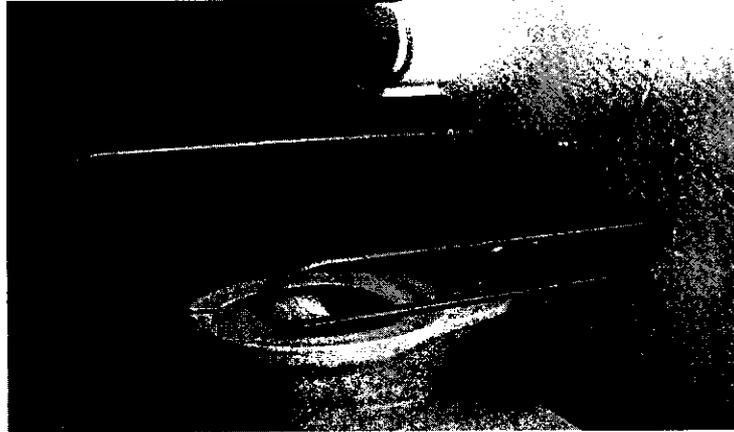
Foto No. 4.- Orinales existentes, se observa que su colocación se encuentra muy abajo, es necesario subirlo a una medida estándar y cambiarlo por uno nuevo y de tamaño mediano
