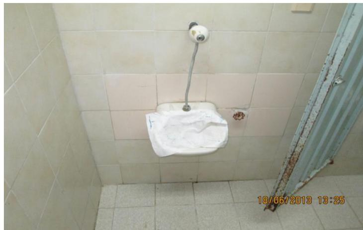
Foto No. 5- División intermedia existente, debe ser reemplazada por división en acero inoxidable
