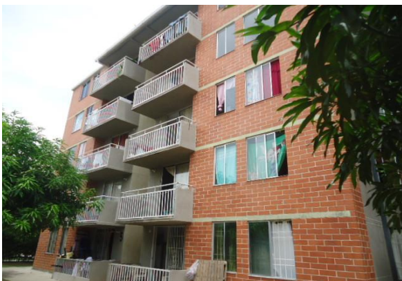
TORRE DEL APARTAMENTO
