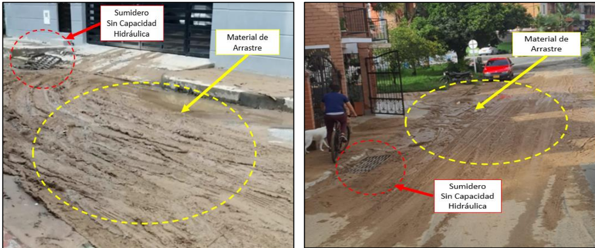
Imagen 8. Sumideros Colapsados y material de arrastre del evento.
