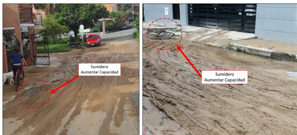
Imagen 13. Localización de sumideros para ampliación de diámetro,
