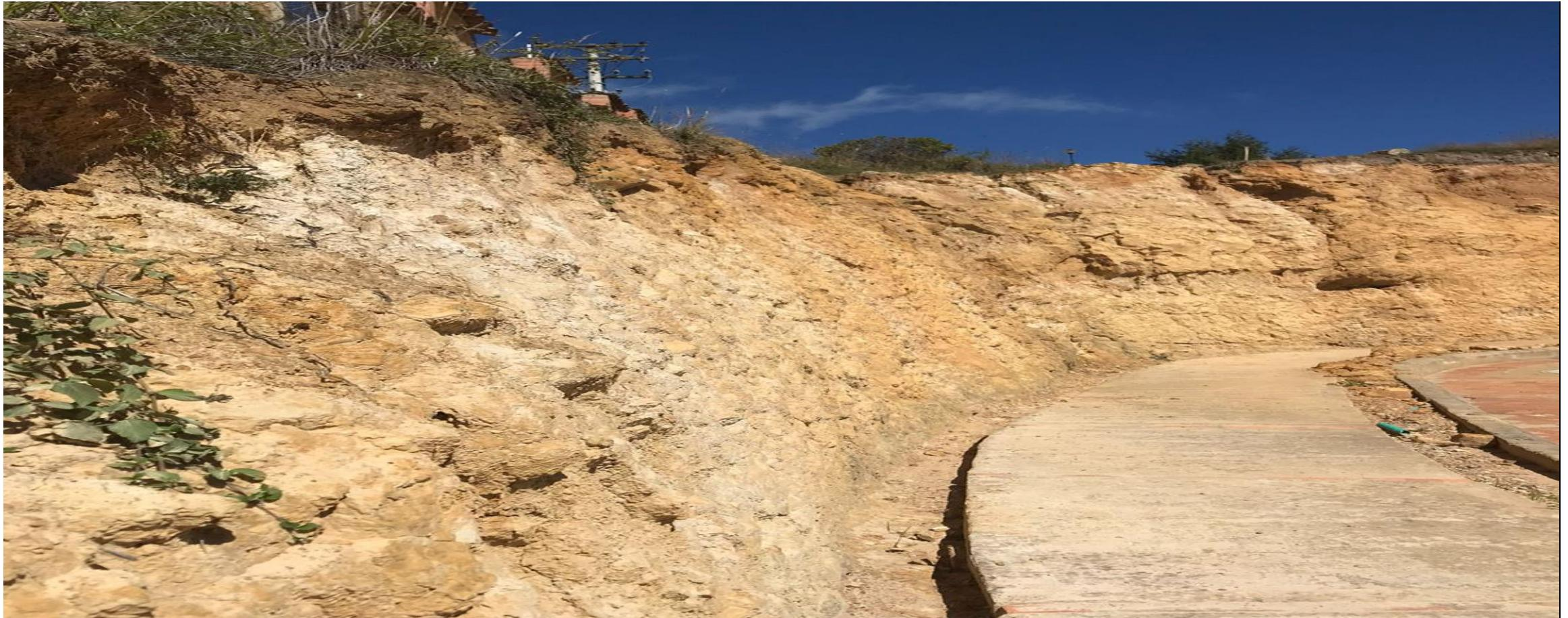
**TALUD QUE REQUIERE OBRAS DE ESTABILIZACION Y CONTROL DE EROSIONES**
