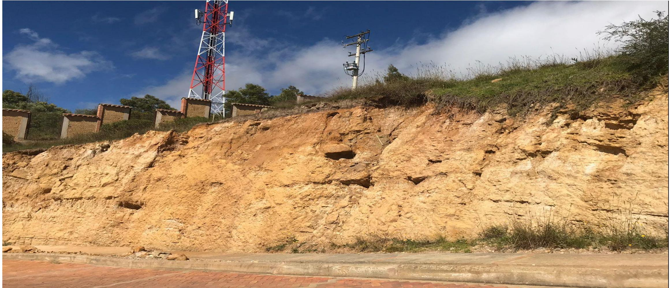
**TALUD QUE REQUIERE OBRAS DE ESTABILIZACION Y CONTROL DE EROSIONES**
