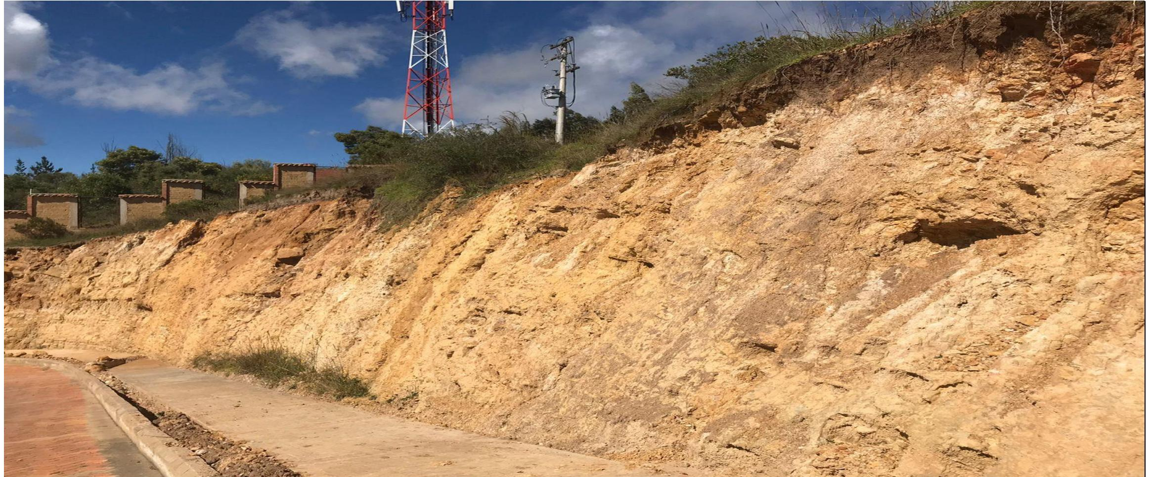
**TALUD QUE REQUIERE OBRAS DE ESTABILIZACION Y CONTROL DE EROSIONES**
